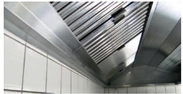
Bild 2 • Dunstabzugshaube mit flammdurchschlagsicheren Aerosolabscheidern
