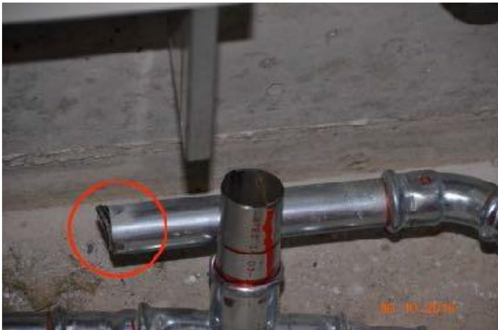
Bild 9: Schräge Schnittkante: hier C-Stahl
