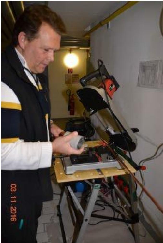
Bild 5: Entgraten der Rohrleitung: hier mit einem Universalentgrater
